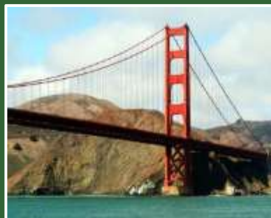
吊橋 (垂直力系統)
